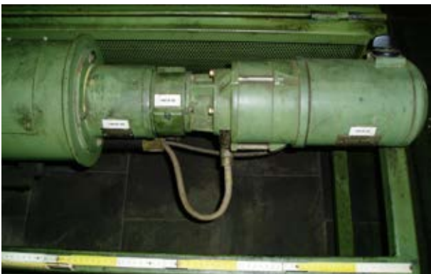
Vorher: DC Tacho mit Fliehkraftschalter / Before: DC tachometer with mechanical switch
