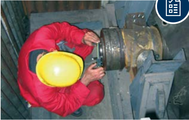
Erfassen der Anbau-Situation vor Ort / Summing up the situation on-site
