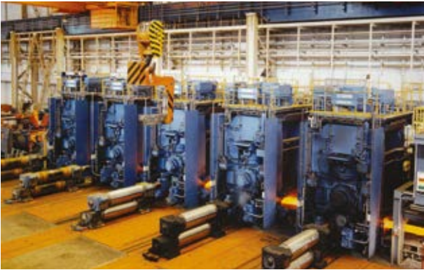
Walzgerüst im Warmwalzwerk / Roll stand in a hot rolling mill
