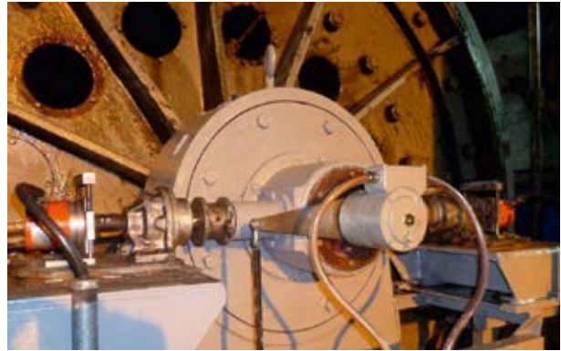
Nachher: Direkt angebautes U-ONE / After: Directly mounted U-ONE
